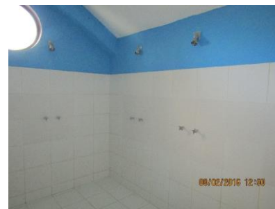
Cambio de palmetas en muros y pintura muros camarín exterior, lado sur.
