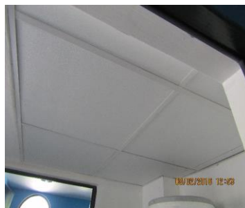
Cambio de cielo en camarín exterior, lado sur.
